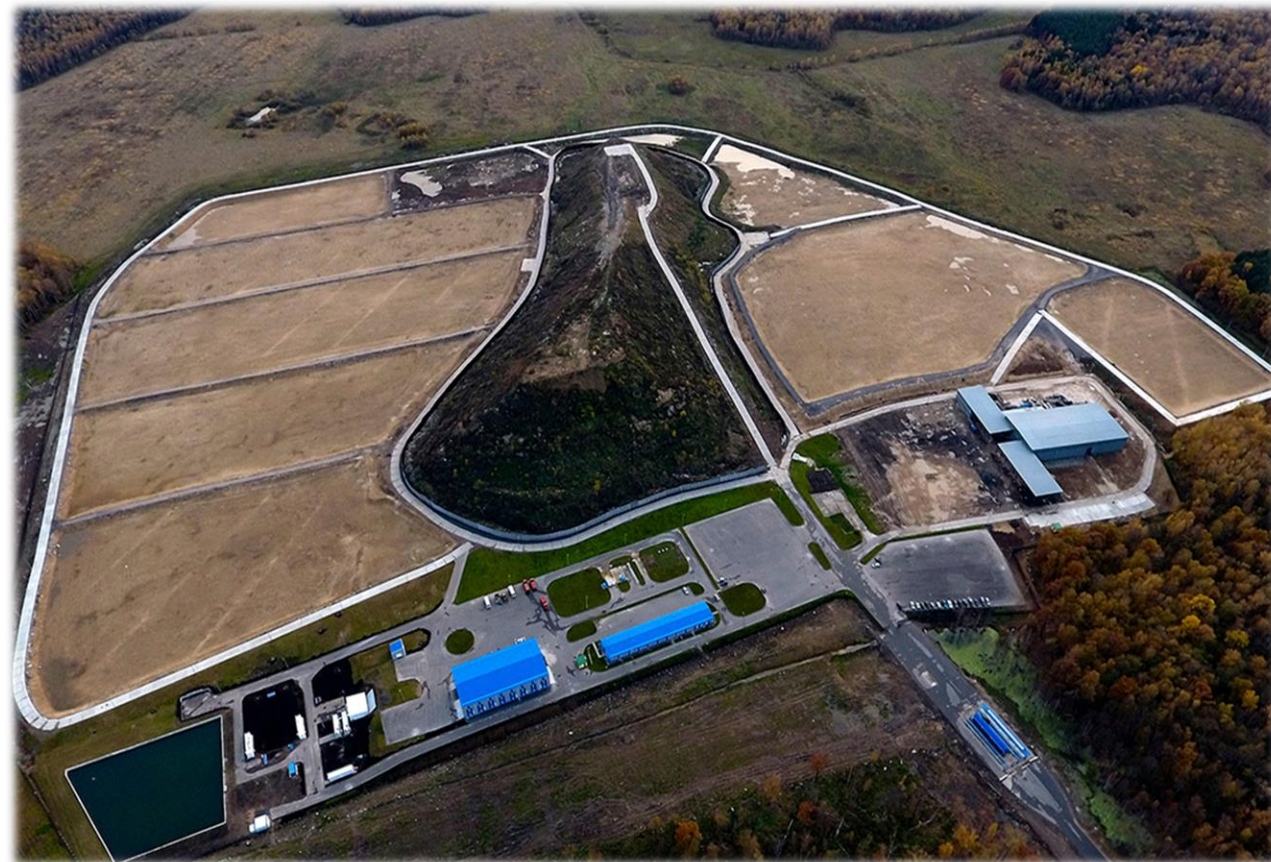
Управление капитального строительства Строительство полигона (ТБО)
