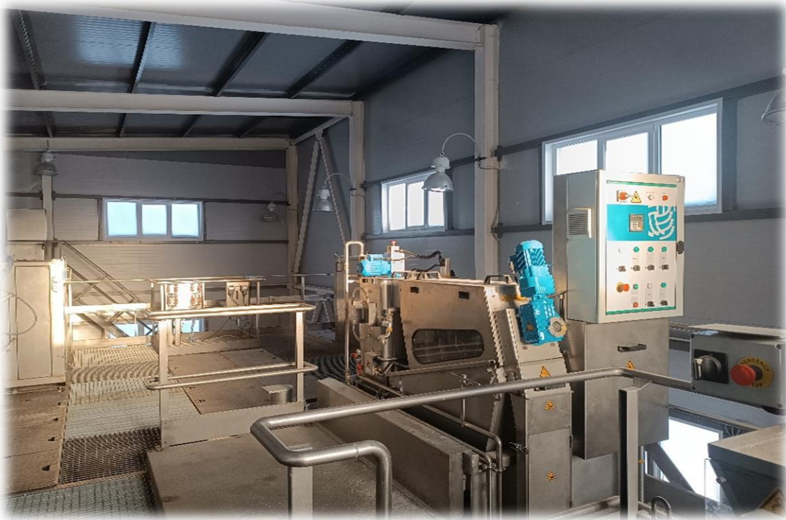
Реконструкция очистных сооружений ЦРБ 2024-2025 гг.
